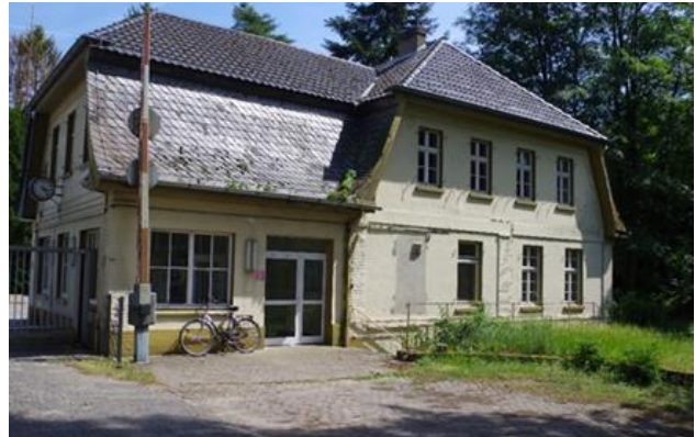
Abbildung 1: aktueller Zustand des Pförtnergebäudes
